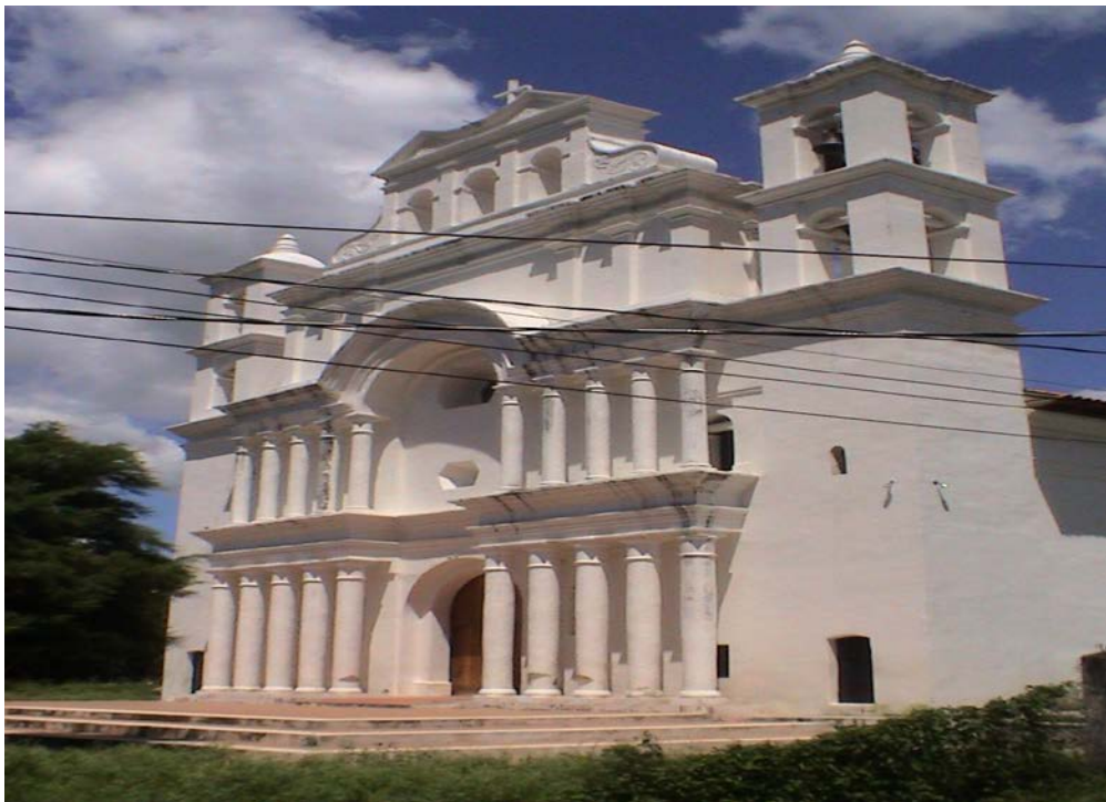
Iglesia de Antigua Ocotepeque, restaurada después de la inundación del Marchala en 1934.
