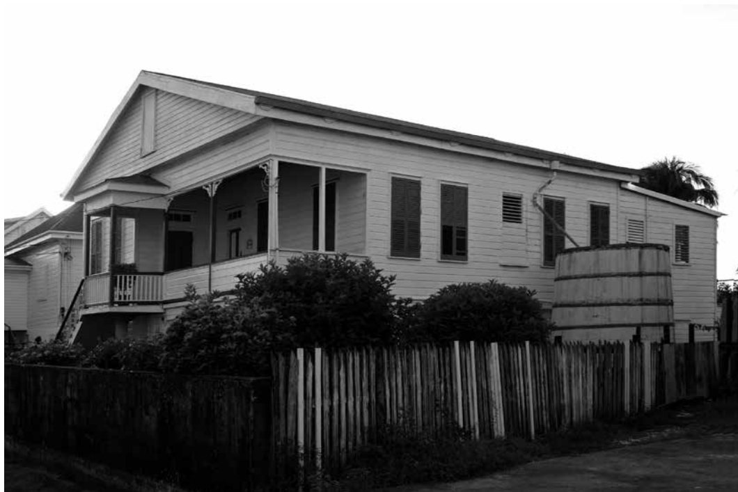
Figura 5. Casa en Cork Street en Belice City, se observa en primer término el curvato y su sistema de captación de las aguas pluviales
